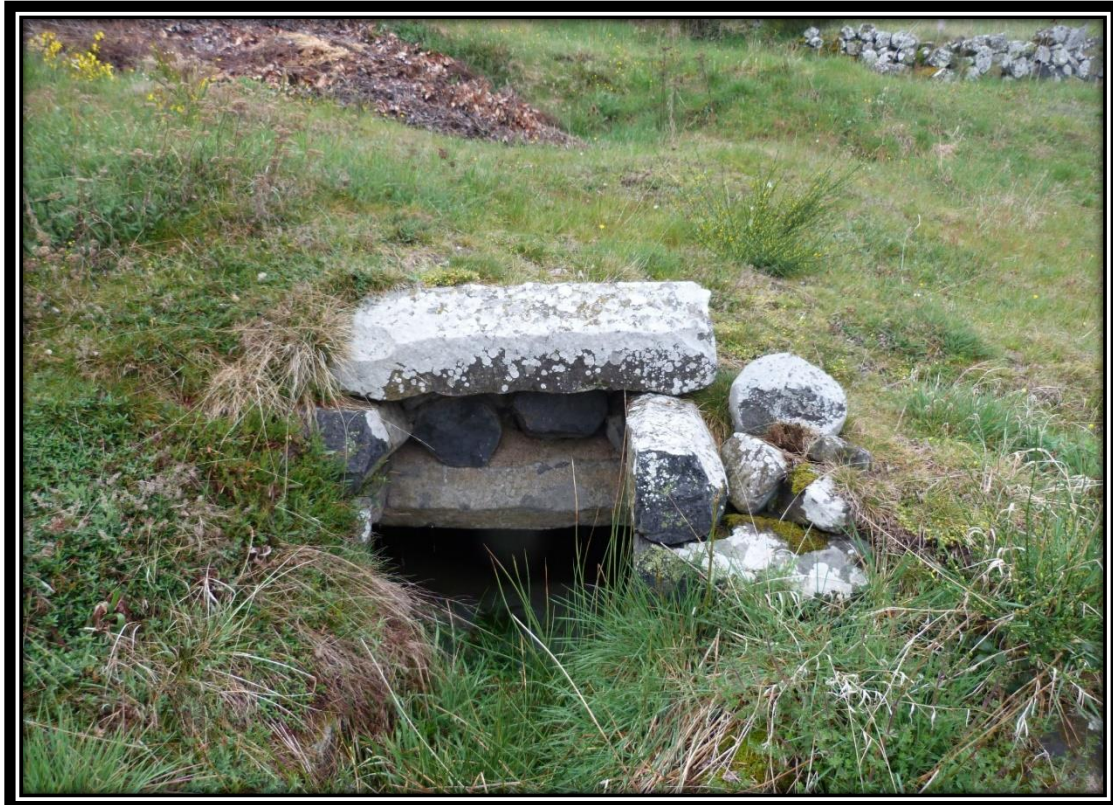
Puits alimentant l'abreuvoir
