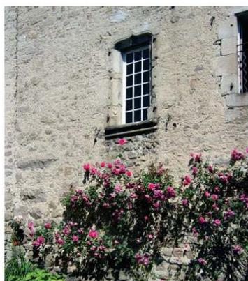
Mur de pierre avec un enduit de jointoiement.
